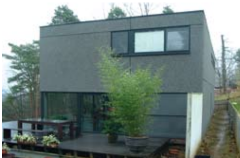
2 Maison à Holsbeek – Aiko arch., Maldegem
