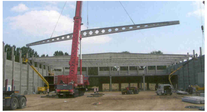
Honda – Alost [58] : (source ERGON) Le cap des 50 mètres est franchi. Le compartimentage est réalisé par les poutres, sans ajours.
