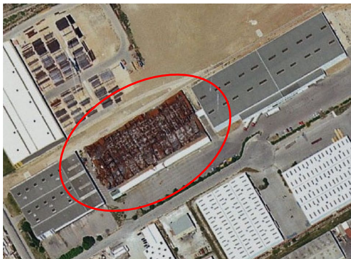
Photo : entrepôt industriel de 7200 m 2 nord Rognac (France) - samedi 15 juin 1996 (source CIMBETON) : Les murs coupe-feu en béton ont parfaitement isolé l'incendie et empêché sa propagation aux entrepôts voisins.
