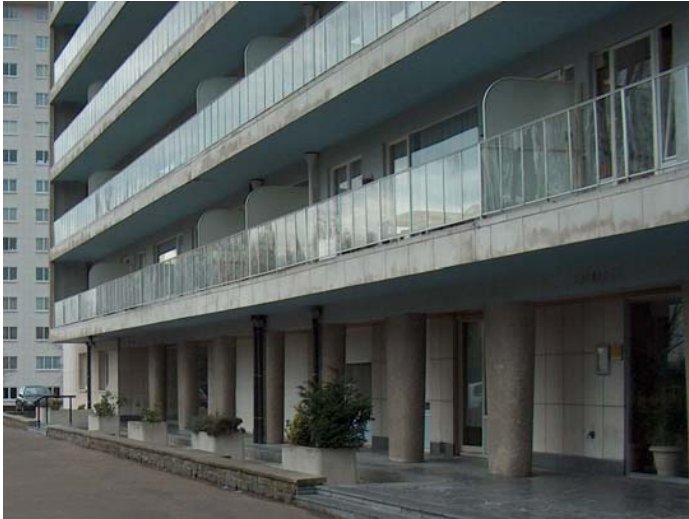
Coursives longeant toute la façade du bâtiment (source [8]). Ces balcons continus constituent des chemins d'évacuation pour les personnes.
