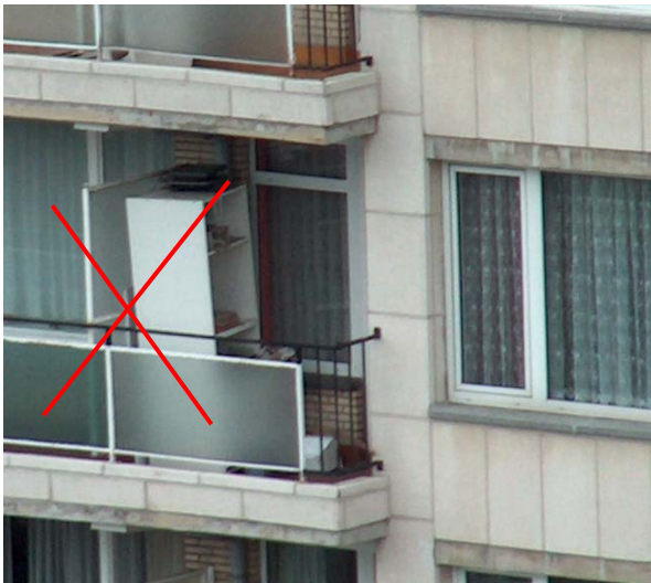
A proscrire : Cette armoire empêche l'évacuation par la course. (source [8])
