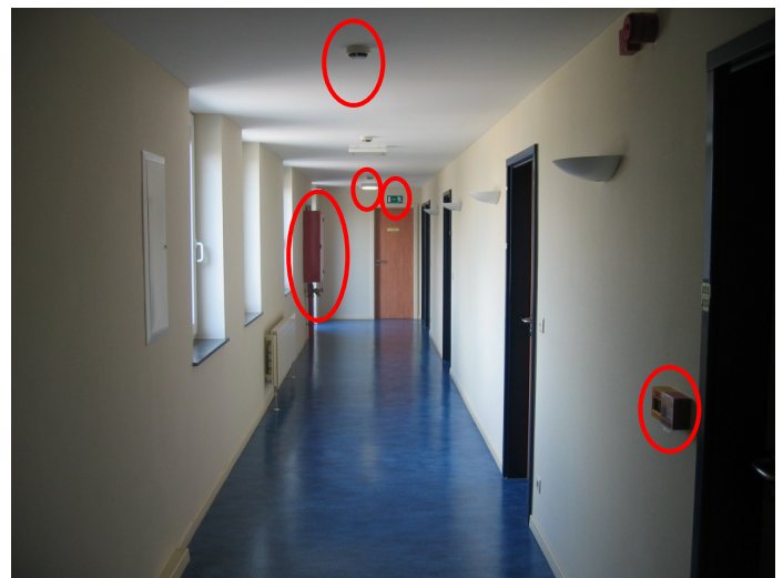
In deze gang zijn meerdere actieve beveiligingen aangebracht : waarschuwingsapparaat, haspel, signalisatiepaneel, rookdetector, noodverlichting (bron : FEBELCEM)
