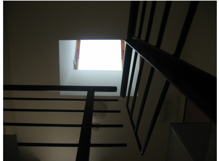
Rookluik aan de top van een trappenhuis (bron : FEBELCEM)
