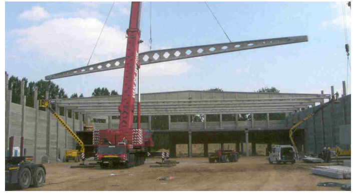
Honda – Aalst [58] : (bron ERGON). De kaap van 50 m is overschreden. De compartimentering wordt gerealiseerd met de balken zonder openingen.
