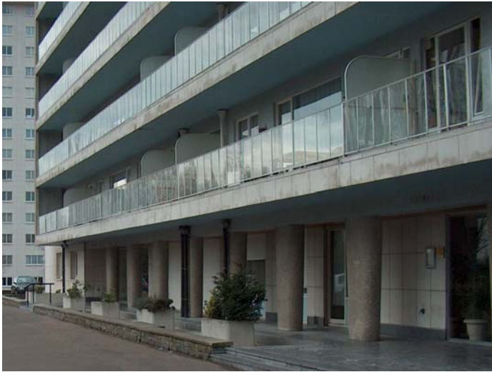
Een gangboord langsheen de volledige gevel (bron [8]). Deze doorlopende balkons vormen een evacuatiweg voor de bewoners
