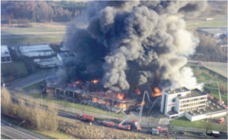
Une destruction complète des bâtiments en l'absence de compartimentation expose l'environnement à une forte agression [photo Guido Coolens]
